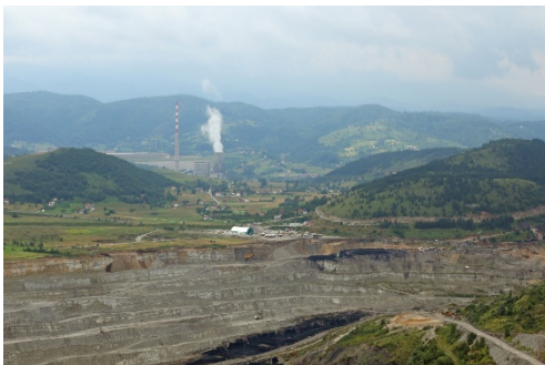
Kohletagebau und Wärmeleistungswerk Pljevlja, Montenegro
